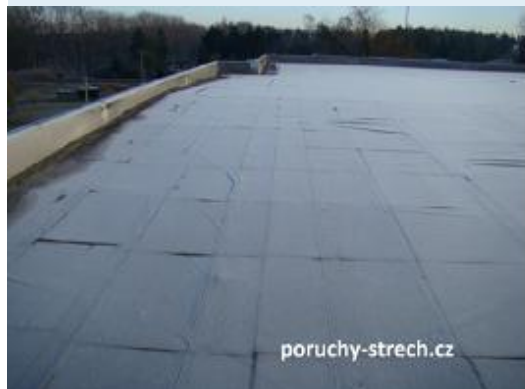
Foto 3 a 4 : výrazné tepelné mosty podél atiky a ve spárách mezi deskami polystyrenu
