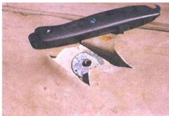
Foto 7 a 8 : Nevhodně zvolený kotevní prvek může časem způsobit perforaci upevněné hydroizolace
