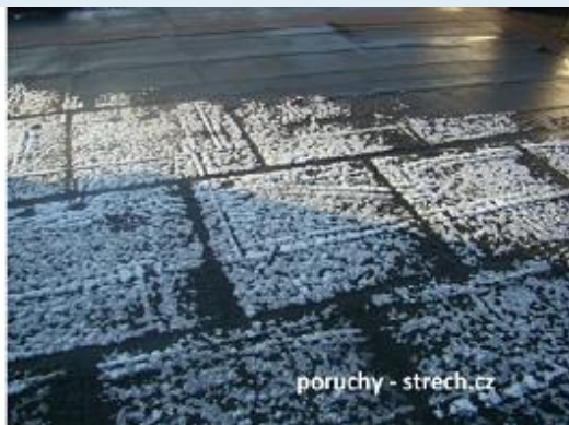
Foto 3 a 4 : výrazné tepelné mosty podél atiky a ve spárách mezi deskami polystyrenu
