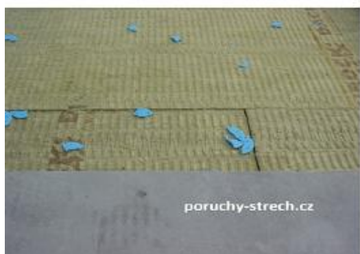
Obr. 9 až 12 : havárie střechy v důsledku selhání kotvení – koroze plastu
